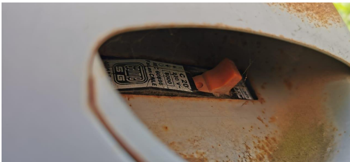
Fotografía 1 Automático ubicado en empalme de 20 Amper [A]
